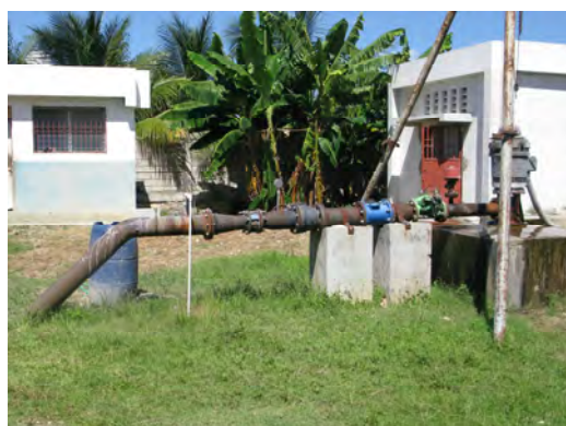
Cité Soleil. La station de pompage Duvivier 4 avant réhabilitation.
