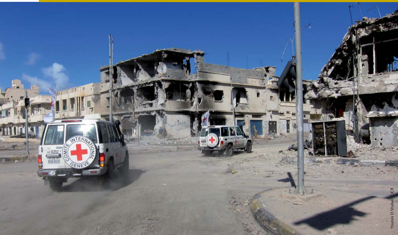
Syrie. Une destruction massive a suivi plusieurs semaines de lourds combats. La cité s'était vidée de ses habitants et seuls quelques civils sont revenus vérifier l'état de leurs maisons. Une équipe CICR est venue faire une visite d'évaluation de la situation.
