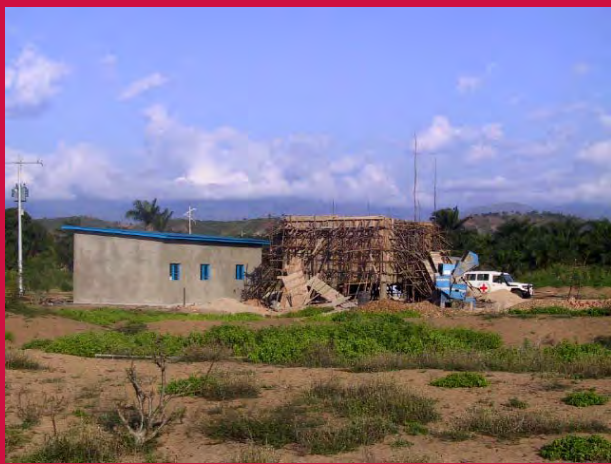
La station de pompage du réseau d'adduction d'eau potable (AEP) de la ville de Rumonge en construction
