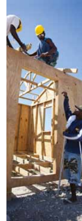
Dans le camp de La Piste, à Port-au-Prince, la FICR a soutenu une équipe d'ouvriers constituée entièrement de sourds pour construire des abris en 2010. Photo : Ben Depp/FICR
