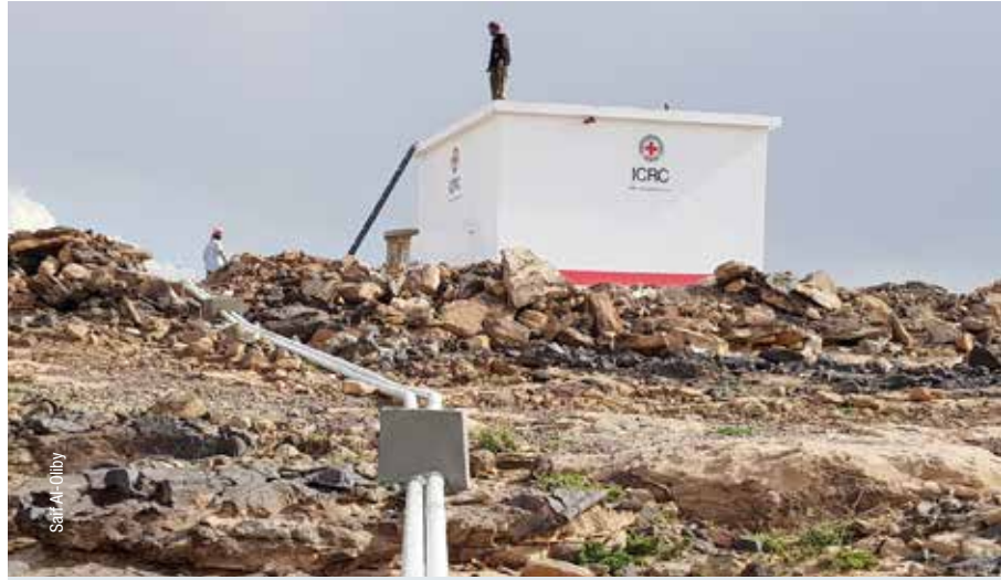
مشروع خزان مياه في منطقة عكوان بمديرية الصفراء في محافظة صعدة.
