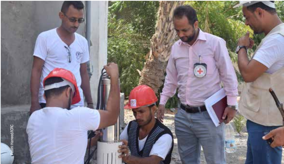
مهندسو اللجنة الدولية يقومون بتركيب مضخة مياه كجزء من مشروع نقاط توزيع المياه في الحالات الطارئة في الحديدة
