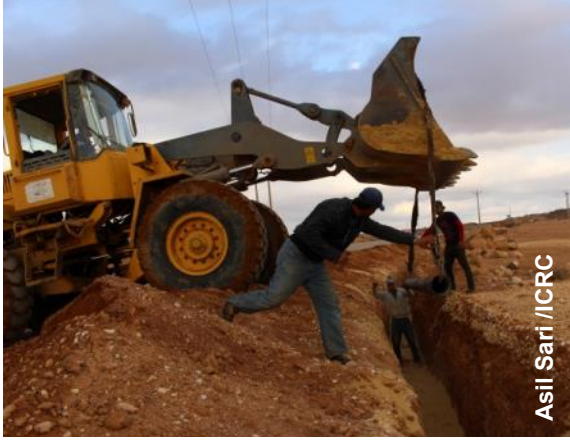
أعمال إعادة تأهيل خطوط نقل المياه في البادية الشمالية تجري على قدم وساق.
