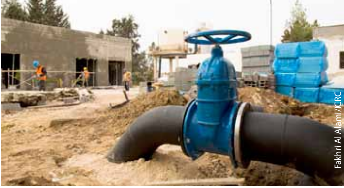
إعادة تأهيل محطة ضخ المياه في بلدة رمثا الحدود في إربد.
