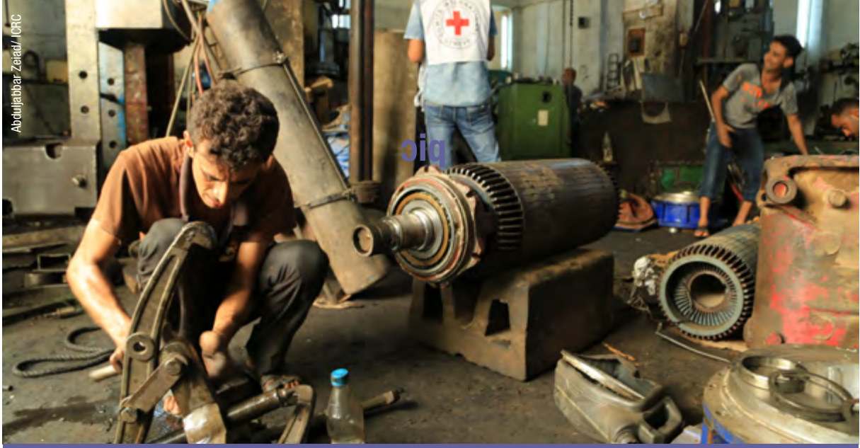
مهندسو اللجنة الدولية يقومون بالإشراف على أعمال إعادة تأهيل مضخات الصرف الصحي بمدينة الحديدة .
