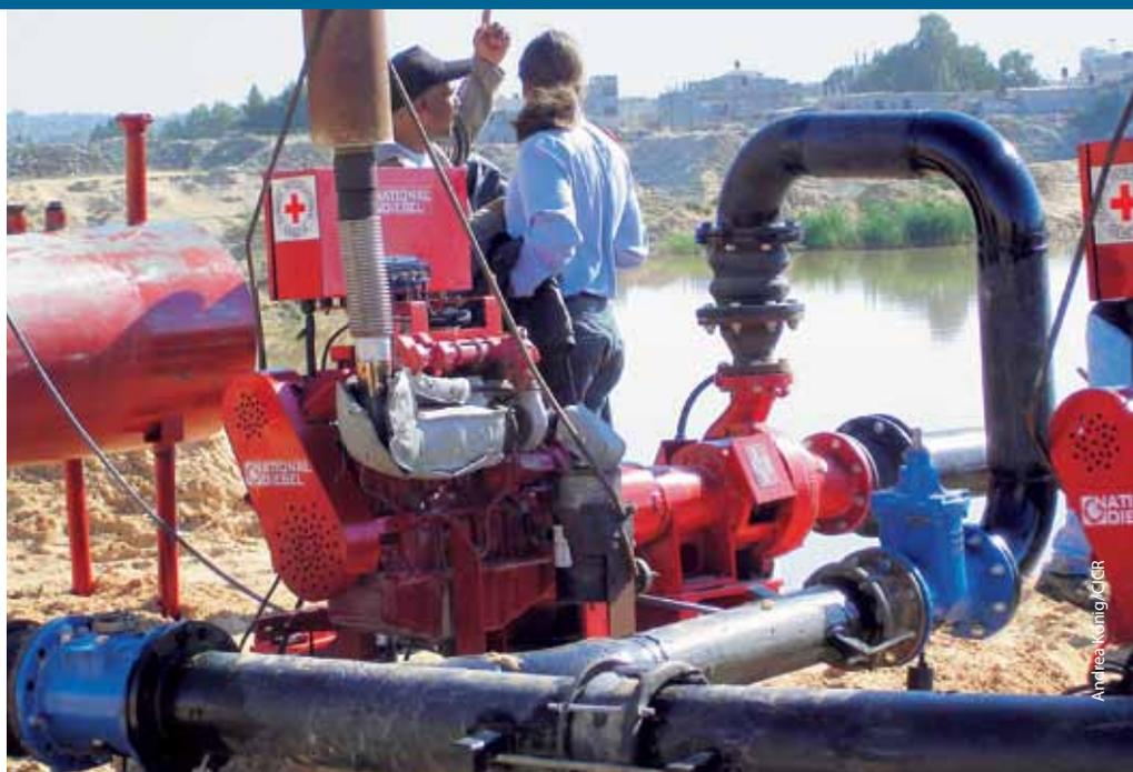
Sistema de bombeo de urgencia en Beit Lahia instalado para evitar una ruptura de los muros del reservorio que recoge las aguas residuales.
