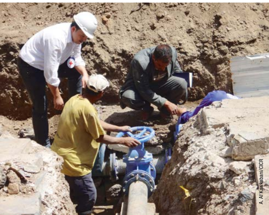
Un ingeniero del CICR y un miembro del organismo local de abastecimiento de agua conectan la principal tubería pública de agua para aprovisionar un distrito de la ciudad yemení de Saná. Diciembre de 2016.
