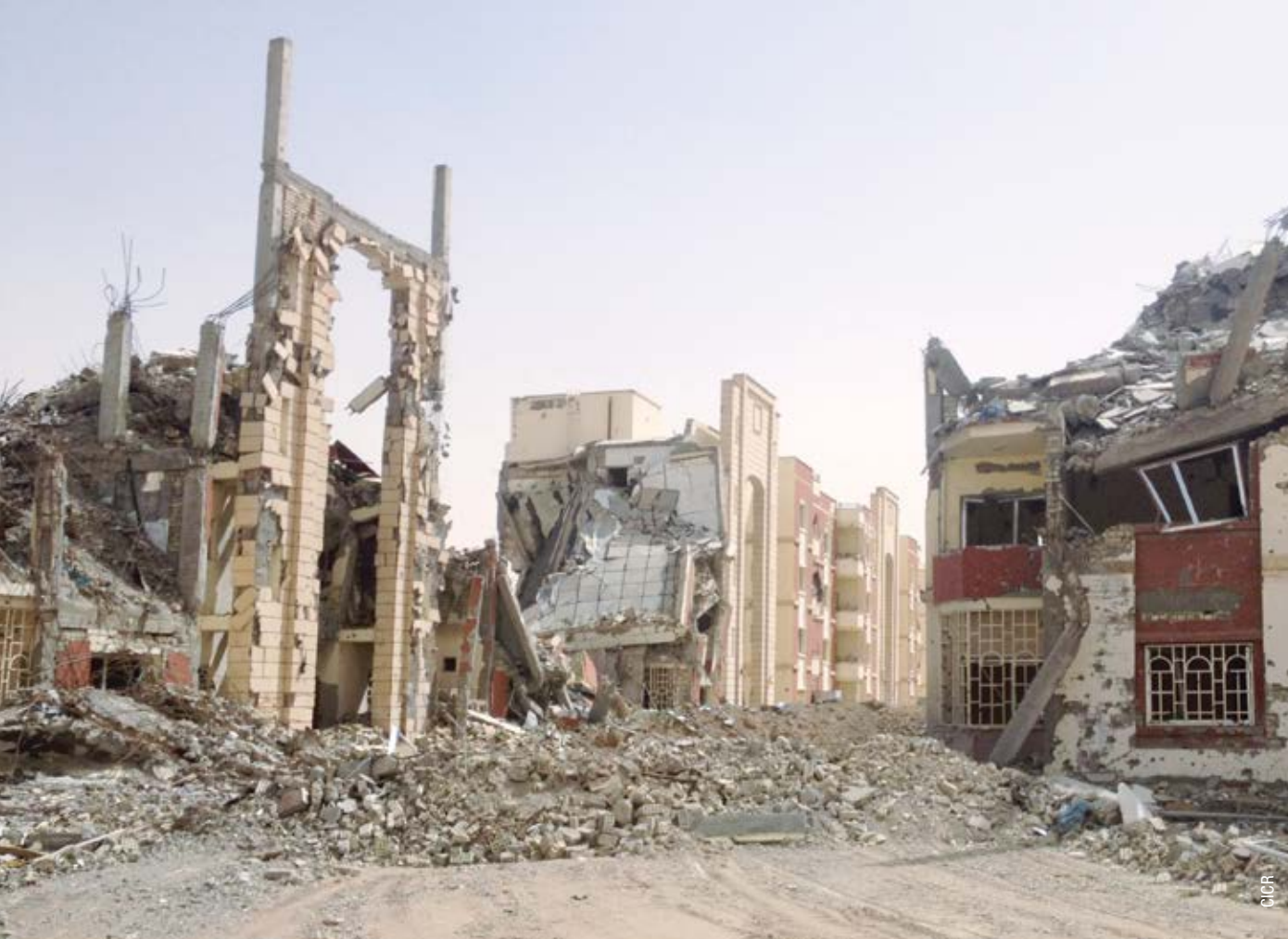
En Ramadi, Irak, a fines de 2015, el 80% de los edificios estaban destruidos.
