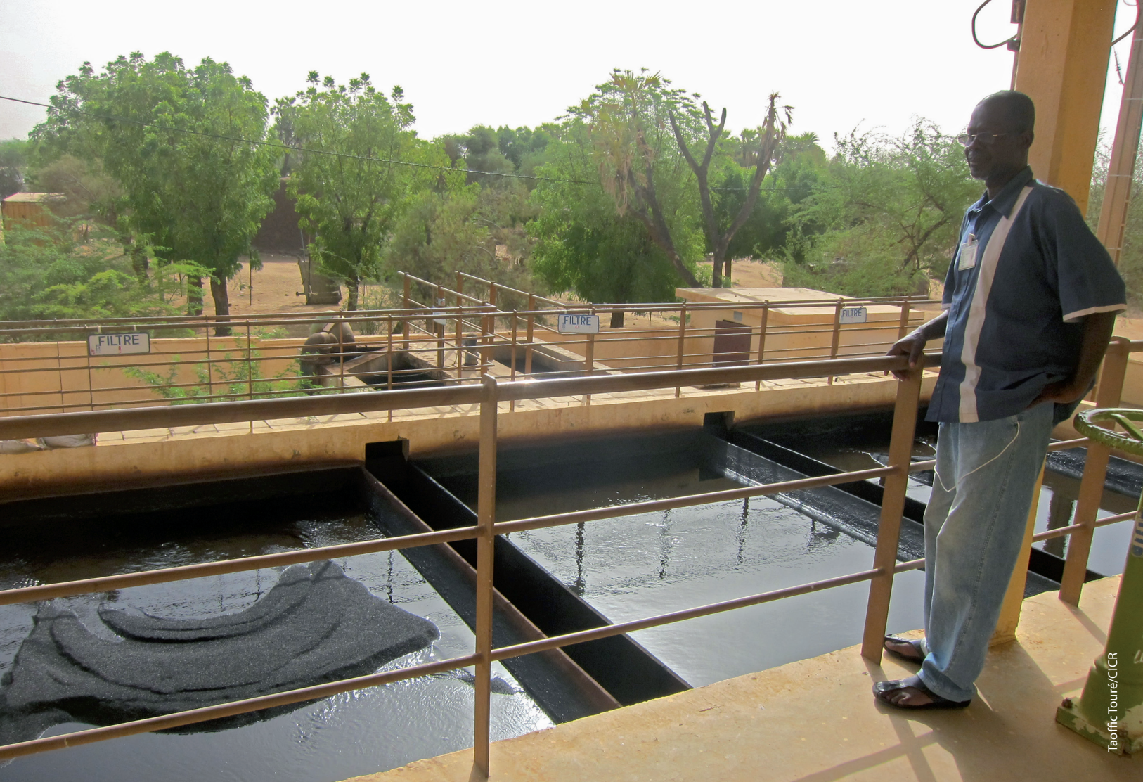
Station de production d'eau potable, Gao, Mali
