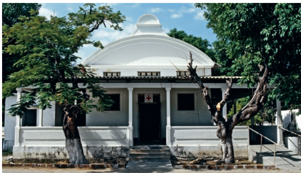
Illustration 2.1.1.2 Façade principale et entrée, 1987 T. Gassmann/CICR
