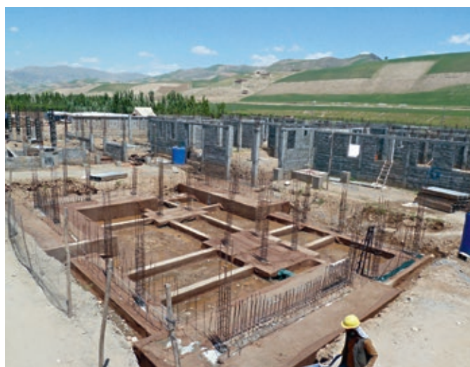
Illustration 2.1.10.3 Vue de l'angle nord-est pendant le chantier – pension, 2014 N. Michaud/CICR
