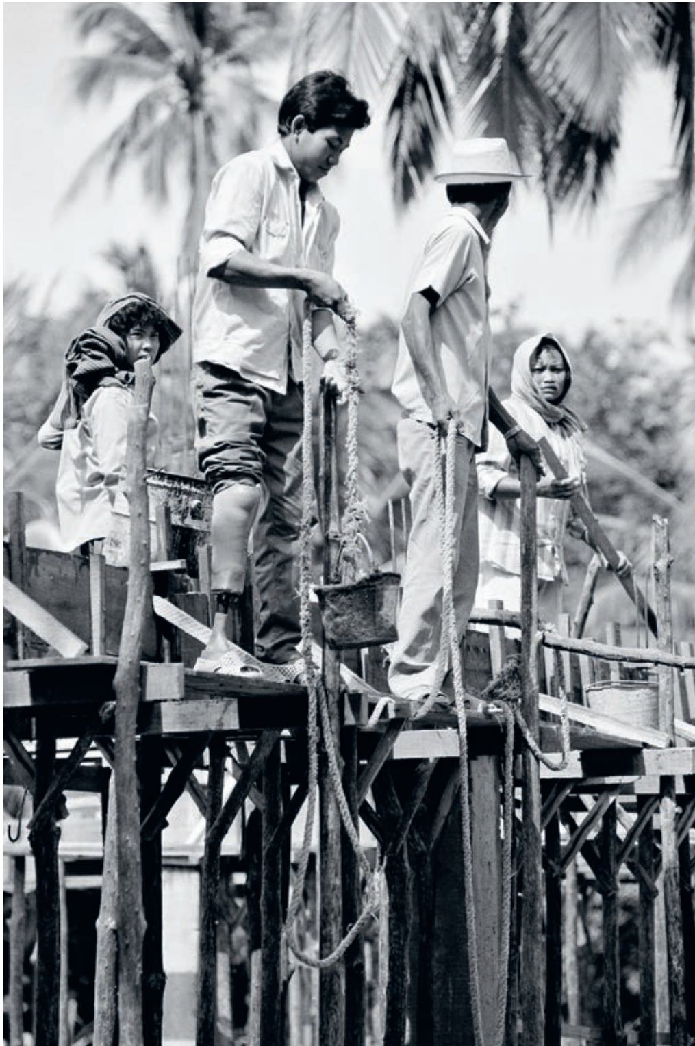
Bénéficiaire travaillant sur le chantier de construction du CRP de Battambang au Cambodge, 1992 S. Corriera/CICR
