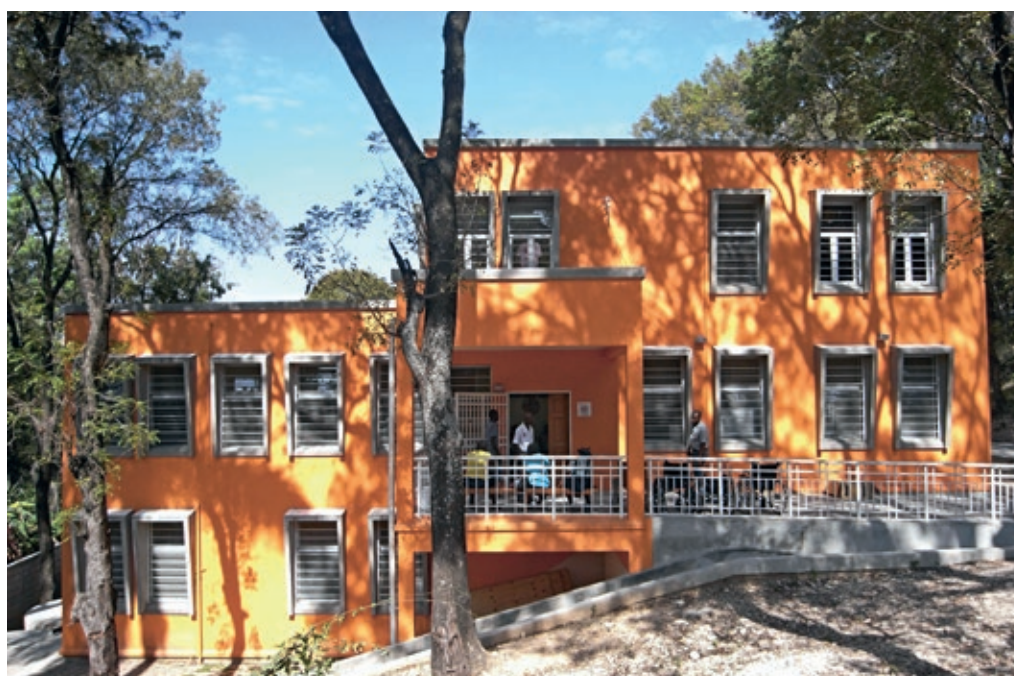
Illustration 2.1.9.2 Vue depuis le sud-est – entrée principale, espace clinique et département PT, 2013 S. Bonnet/CICR
