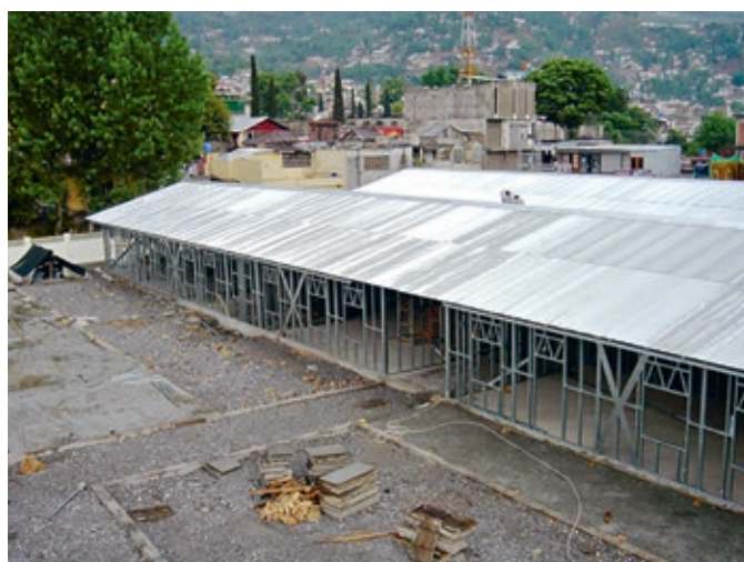
Illustrations 2.1.7.4 et 2.1.7.5 Chantier de construction – édification des structures légères en aluminium, 2007 F. Engler/CICR
