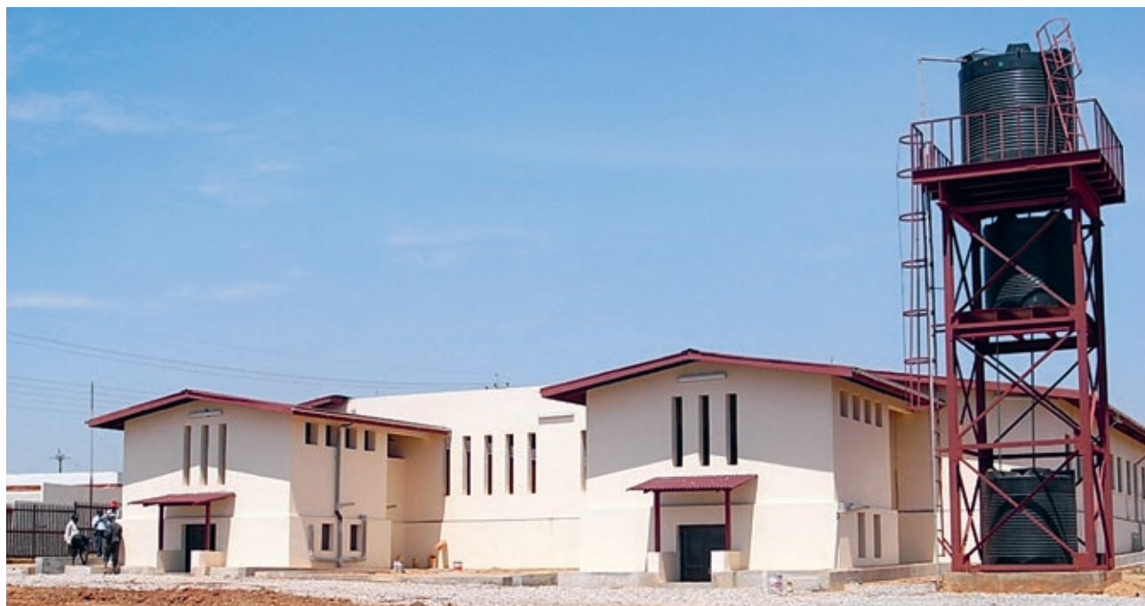
Illustration 2.1.8.3 Vue de l'angle sud-est – salles techniques (007 et 008) en sous-sol, 2008 S. Bonnet/CICR
