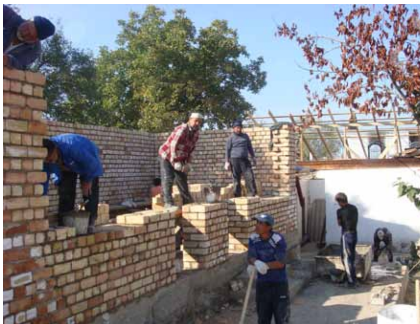
Восстановление разрушенных домов на юге Кыргызстана
