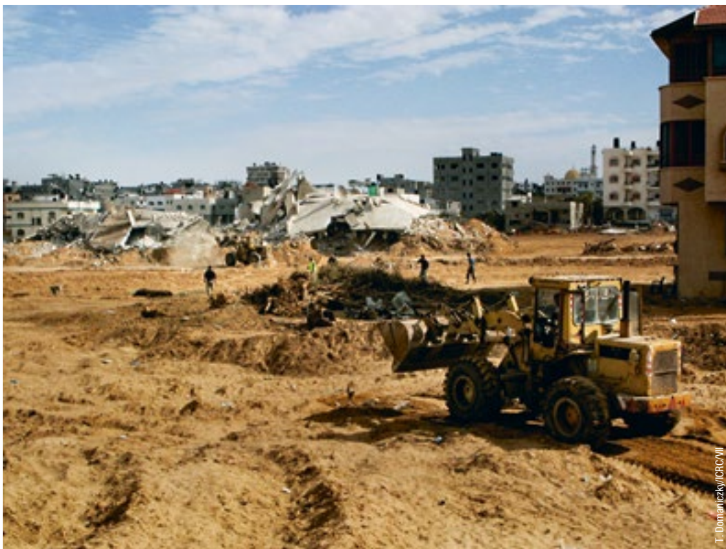
Илл. 37. После войны 2014 г. в Бейт-Лахии (сектор Газа) МККК заключил контракт с местной строительной компанией по восстановлению ценной в сельскохозяйственном отношении земли
