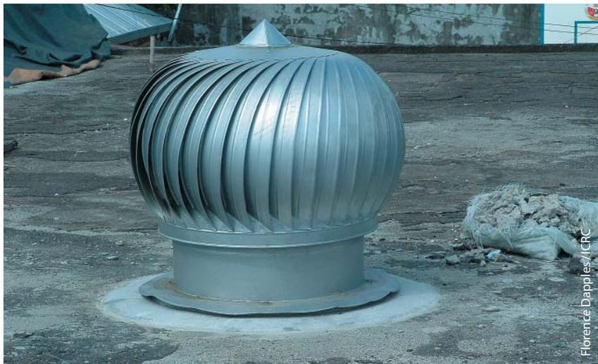
Илл. 11 Простая кровельная система вентиляции, обеспечивающая отвод теплового влажного воздуха
