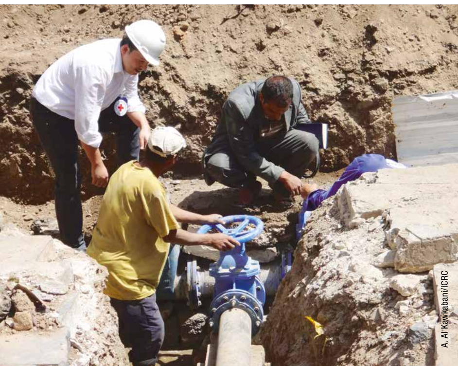
Инженер МККК и сотрудник местного управления водоснабжения подключают один из районов столицы Йемена Саны к центральному городскому водопроводу. Декабрь 2016 г.
