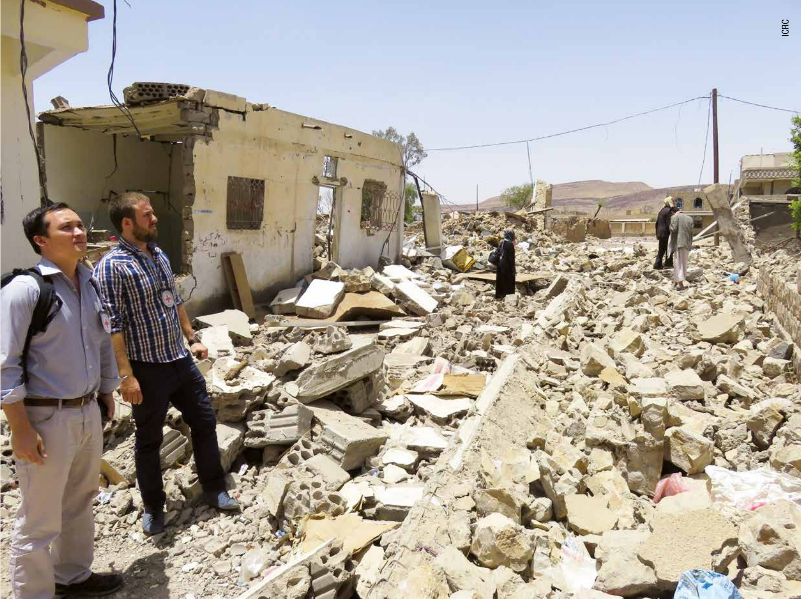
Сотрудники МККК оценивают разрушения, причиненные в ходе продолжающегося конфликта в Сааде. Июль 2015 г.
