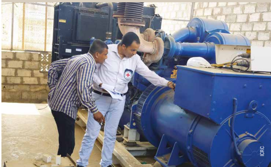
Инженер МККК проверяет мотор электрогенератора в больнице Эт-Таура в городе Ходейда. Май 2016 г.
