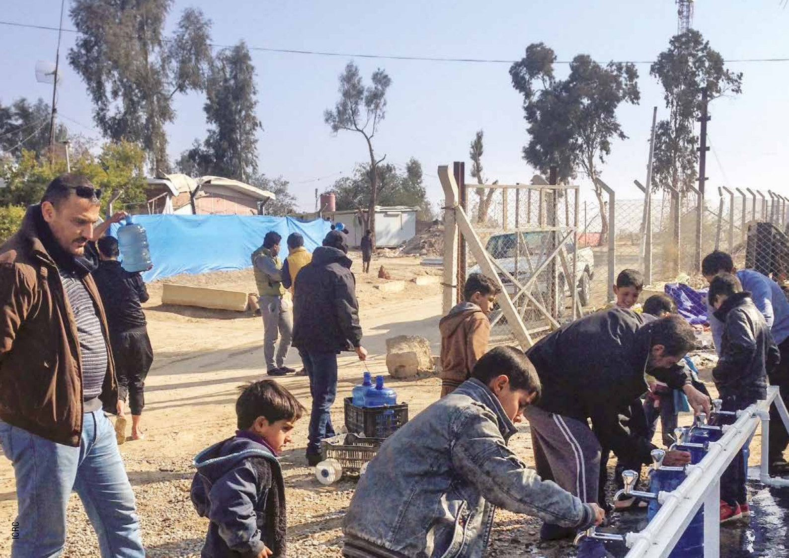
Медина-эль-Сияхийя, Ирак. Жители наполняют бутылки водой. МККК восстановил городскую насосно-фильтровальную станцию, пострадавшую от военных действий. Январь 2015 г.
