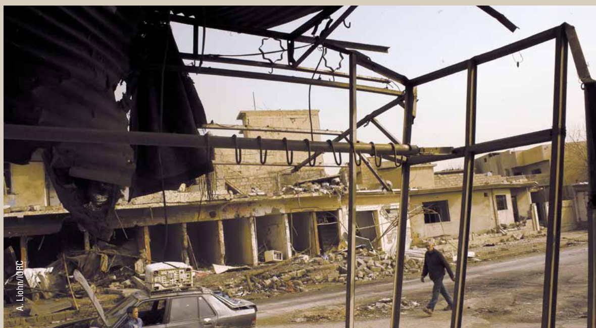
Разрушенный жилой квартал в восточном Мосуле. Февраль 2017 г.
