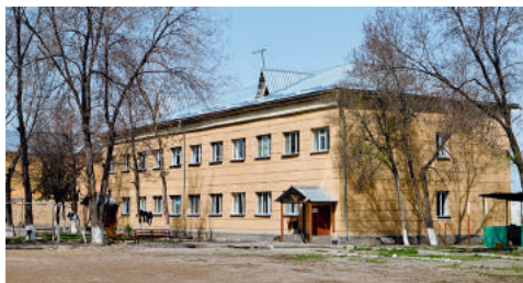
Отремонтированные здания для пациентов с негативной формой туберкулёза в исправительном учреждении №31
