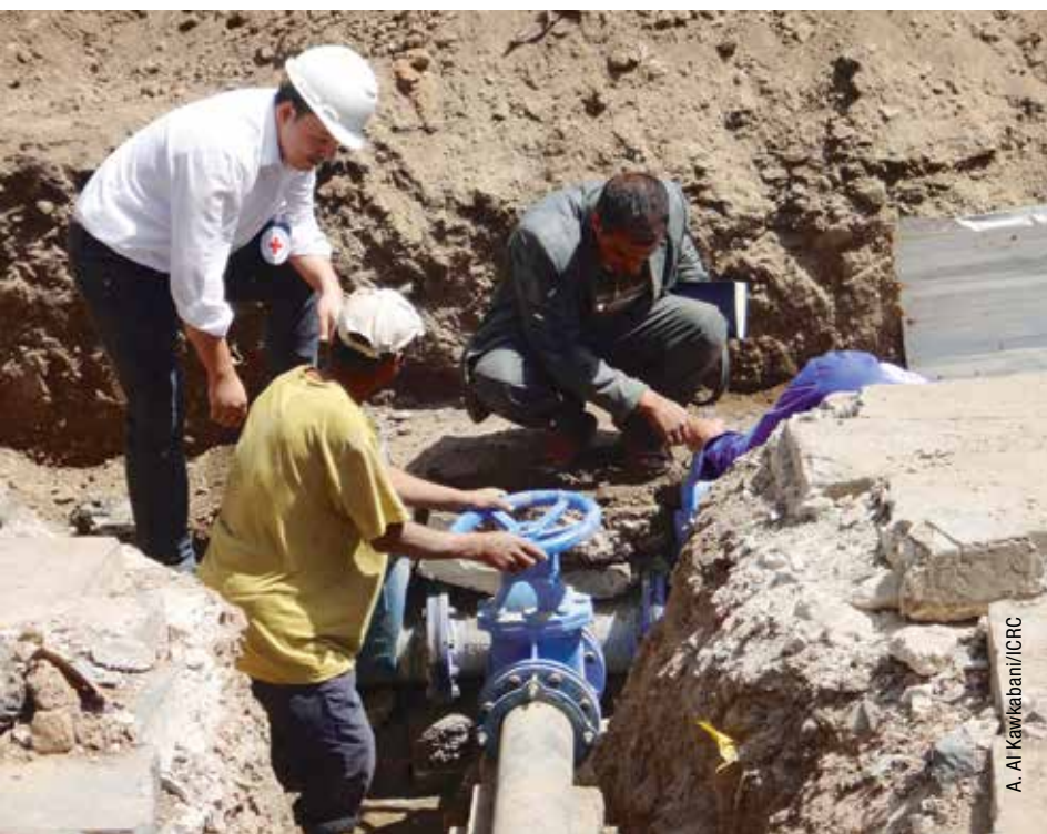
2016年12月，也门萨那。一位红十字国际委员会的工程师与当地水务部门的工作人员正在为一个地区接通主要公共供水管道。
