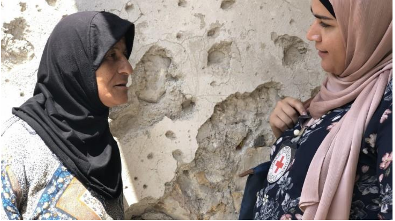
Suriye - Halep - Sığınma evi projesi / Su/sanitasyon Um Mohammad, 56 yaşında, dul ve iki çocuğu var. Çatışma nedeniyle evi tamamen hasar gördü. Yousef Ali, ICRC
