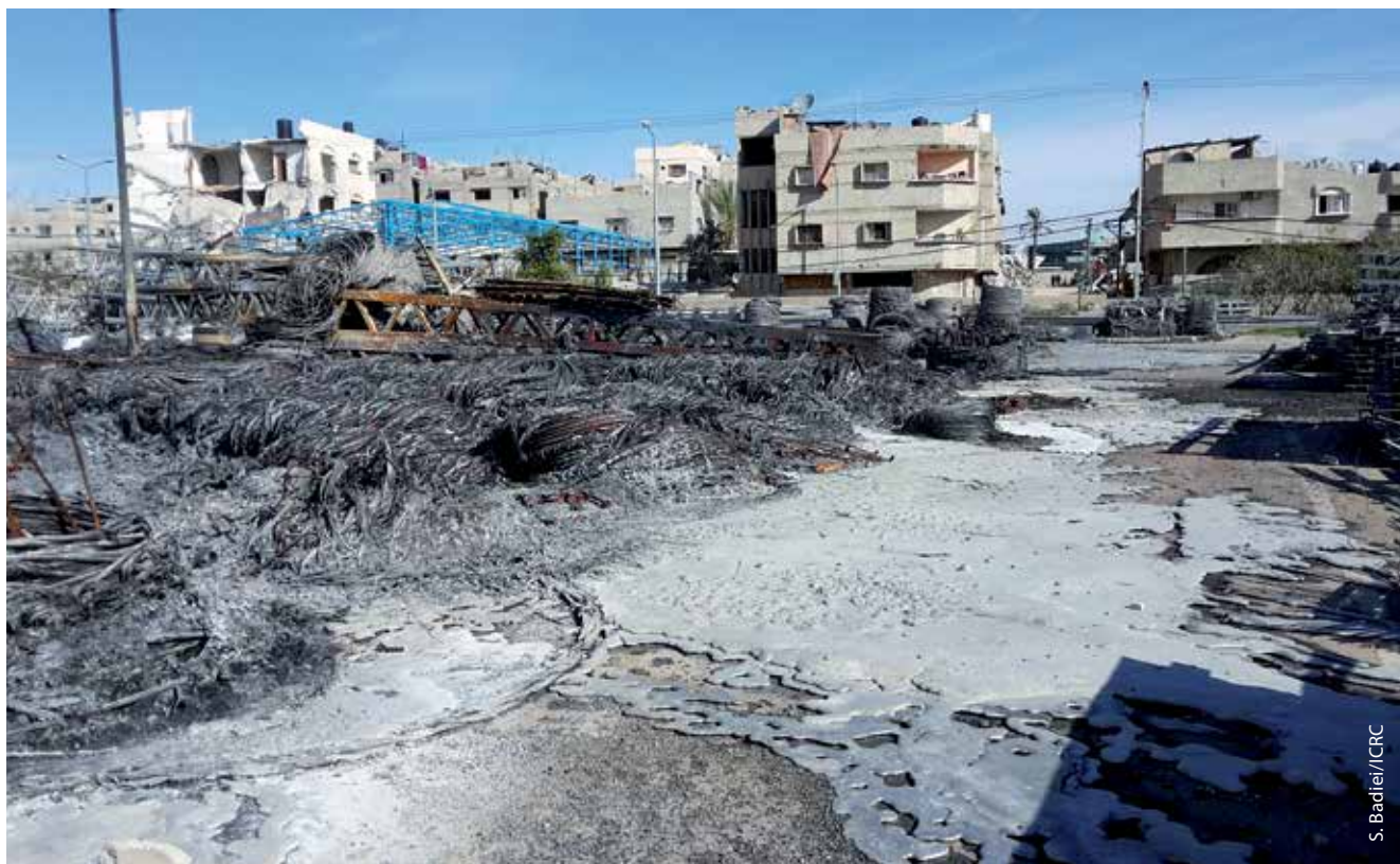
照片6。 必须理解基本服务之间的相互关联性，并将其妥善纳入针对服务崩溃的紧急应对中，避免适得其反。仅翻新某区域出现故障的供水网络而不修理损坏的排污管网，可能造成污水渗入街道，增加公众的公共卫生风险。(亚丁，2015年)
