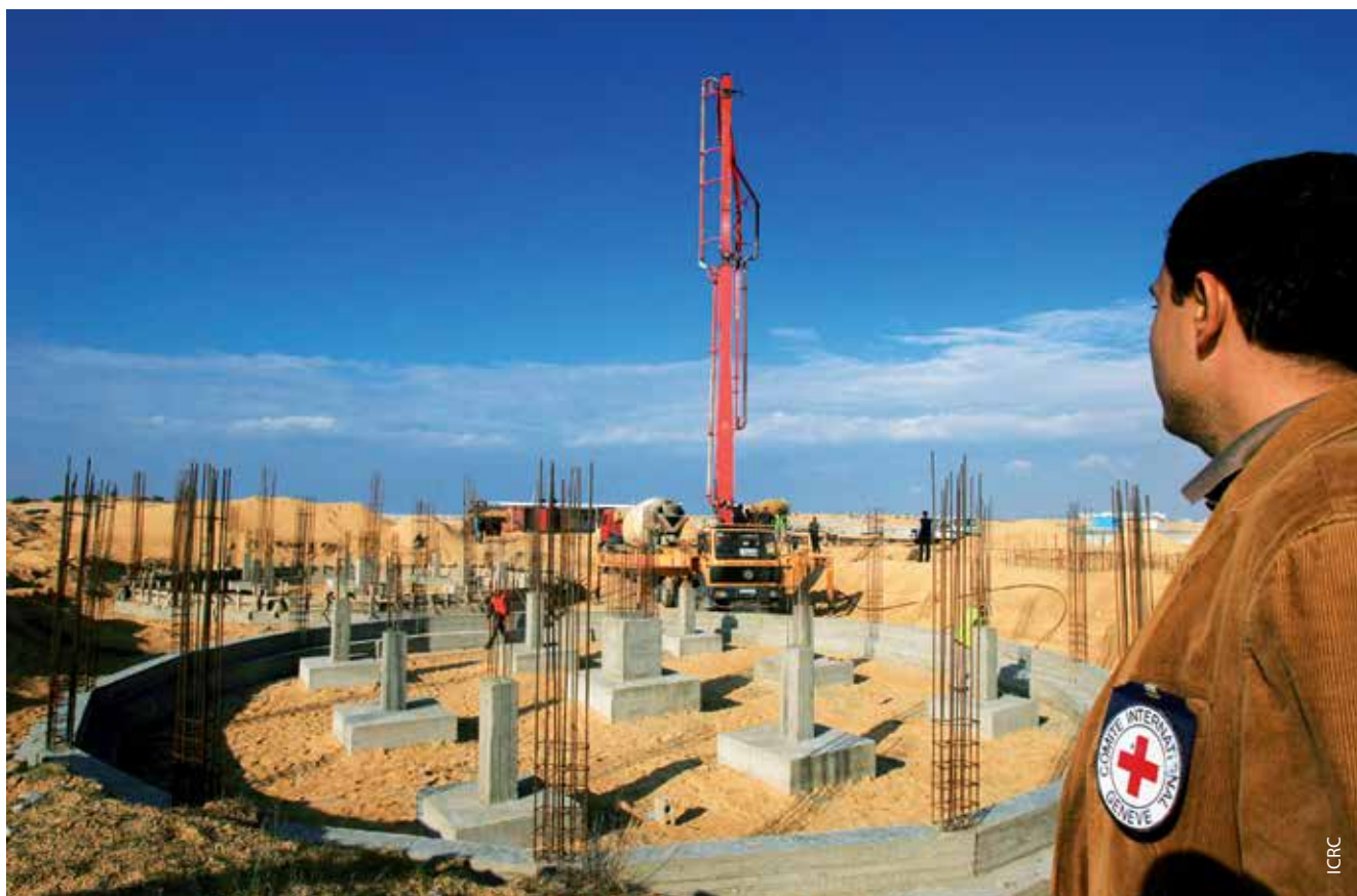
照片9。监督当地承包商对拉法市污水处理厂的施工情况，15万居民从中受益。(加沙地带，2009年)
