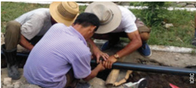
在定平邑铺设管道。
