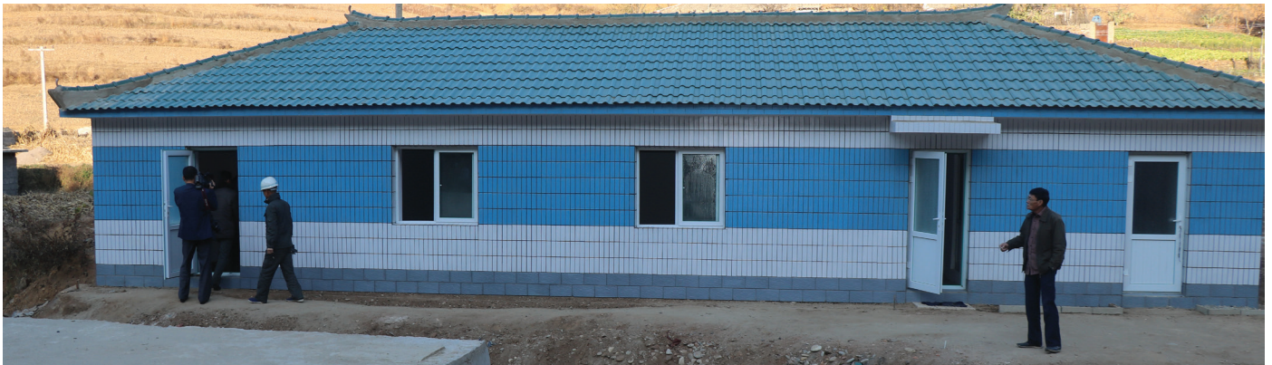
价川市供水系统在建的员工宿舍。
