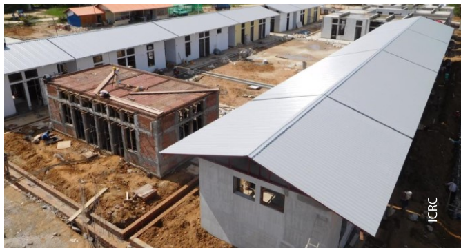
掸邦景东总医院正在兴建一座身体康复中心
